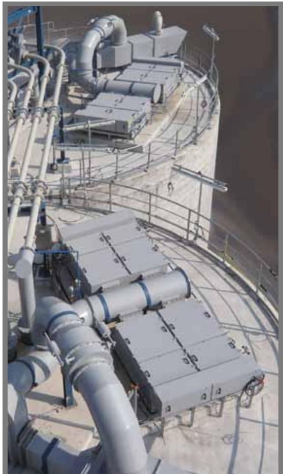
Eine kompakte Bauweise mit zahlreichen geometrischen Variationsmöglichkeiten und verschiedenen Filtertaschenlängen erlaubt die optimale Anpassung an verfahrenstechnische und räumliche Gegebenheiten.
